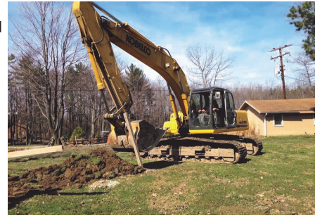
The first dig
